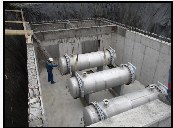
Hőtároló tartályok, hőcserélők beemelése
